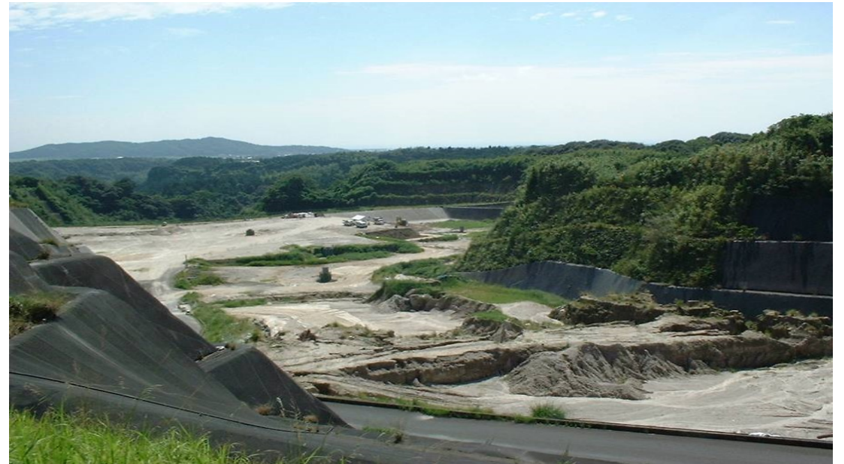
大崎町の現在の埋立処分場
